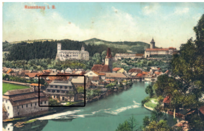
Dům ruční papírny čp. 21 před přestavbou na bytové jednotky.
